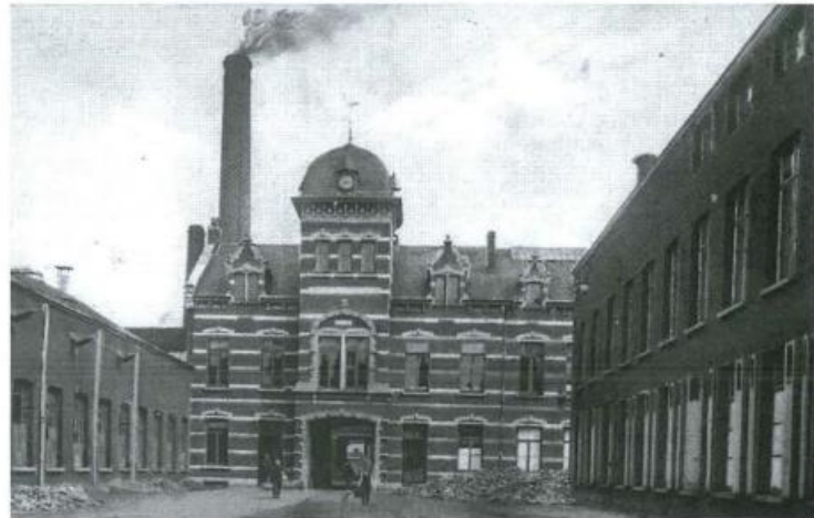
Ingang van de fabriek. Het hoofdgebouw zoals het er vandaag nog uitziet.
